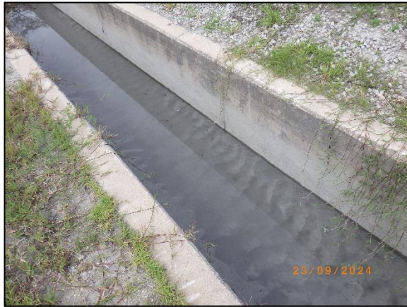
รูปที่ 2-15 รางระบายน้ำล้อมรอบบริเวณ กองพักเถ้าชั่วคราวของโครงการ
