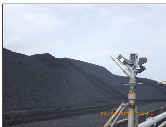
รูปที่ 2-3 หัวฉีดสเปรย์น้ำบริเวณลานกองถ่านหิน ของโครงการฯ
