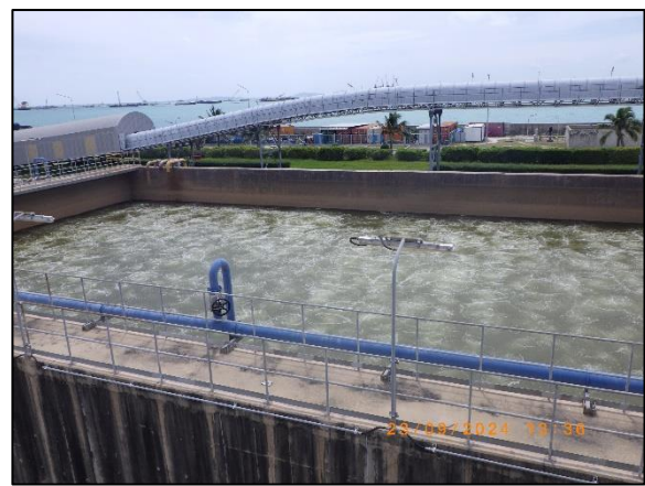
รูปที่ 2-23 ระบบบำบัดน้ำเสียสำหรับรองรับน้ำเสีย จากกระบวนการผลิตกระแสไฟฟ้า
