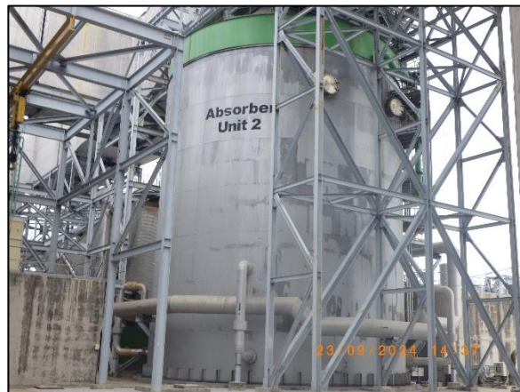
รูปที่ 2-7 ระบบดักจับก๊าซซัลเฟอร์ไดออกไซด์ (Sea Water FGD)
