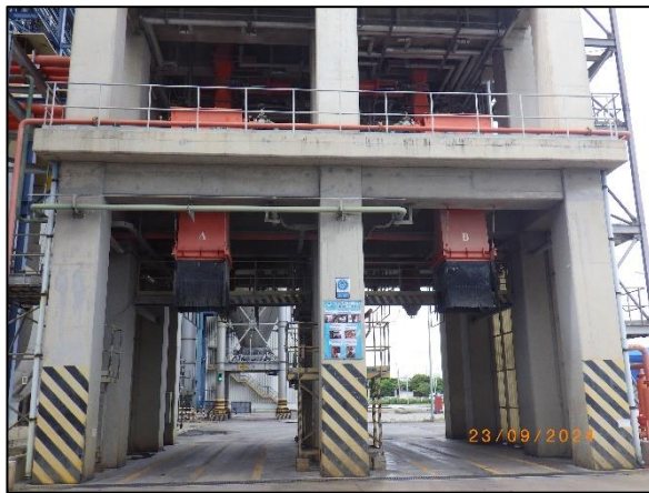
รูปที่ 2-17 จุดขนถ่ายเถ้าลอยภายในพื้นที่โครงการ
