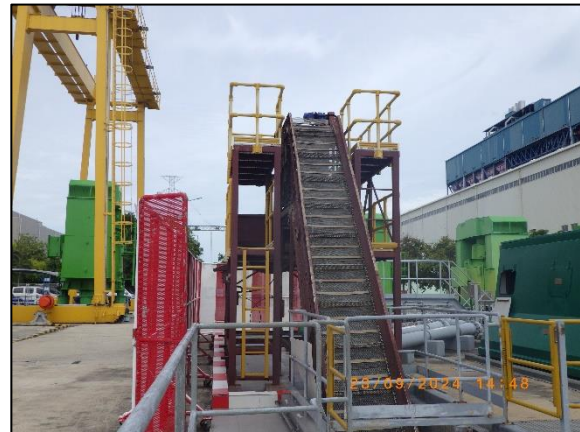
รูปที่ 2-33 อุปกรณ์ Mesh Belt Conveyor บริเวณคลองส่งน้ำหล่อเย็น
