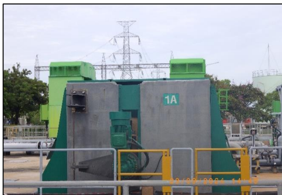
รูปที่ 2-34 อุปกรณ์ Bar Screen & Traveling Screen บริเวณคลองส่งน้ำหล่อเย็น
