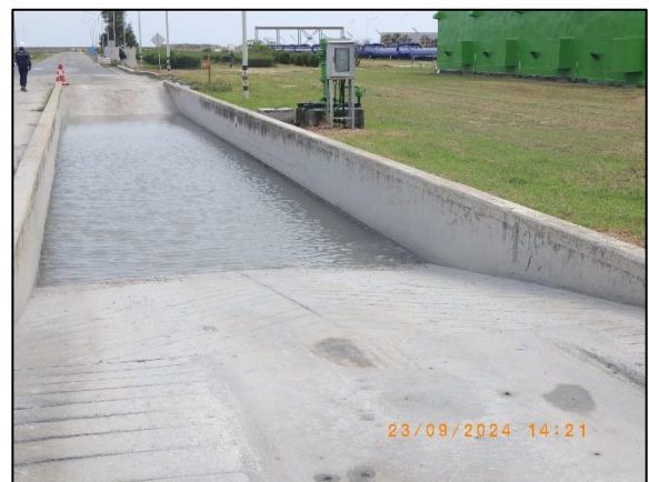
รูปที่ 2-14 บ่อล้างล้อรถบรรทุก บริเวณลานกองเก็บเถ้าชั่วคราว
