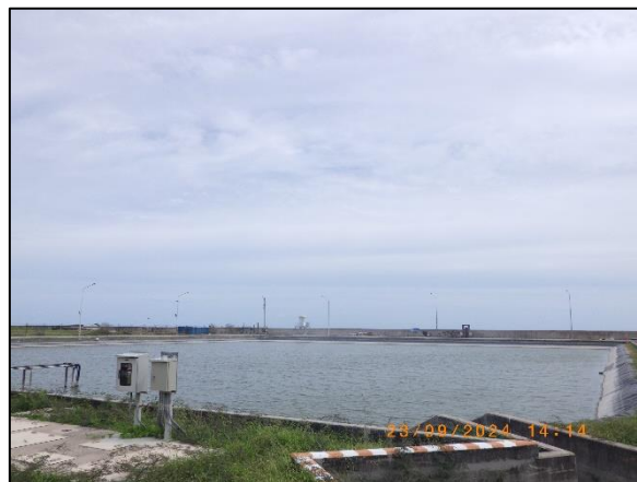
รูปที่ 2-28 บ่อรวบรวมน้ำจากบริเวณพื้นที่ลานกองถ่านหินที่ปูพื้นด้วยแผ่นพลาสติกชนิด HDPE
