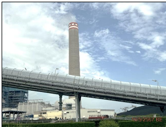
รูปที่ 2-1 สายพานลำเลียงระบบปิดบริเวณลานกองถ่านหินของโครงการฯ
