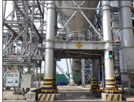
รูปที่ 2-16 จุดขนถ่ายเถ้าหนักภายในพื้นที่โครงการ
