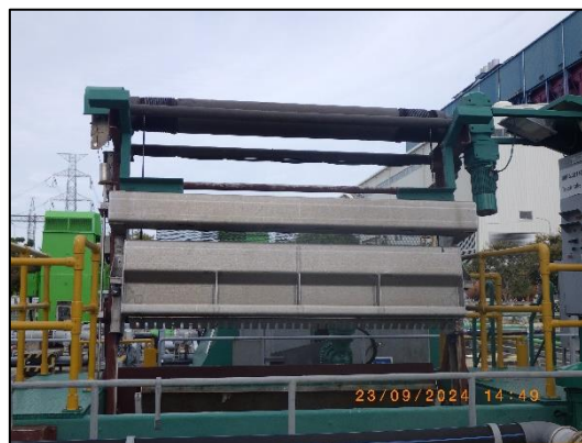
รูปที่ 2-36 อุปกรณ์ Trash Rake บริเวณคลองส่งน้ำหล่อเย็น
